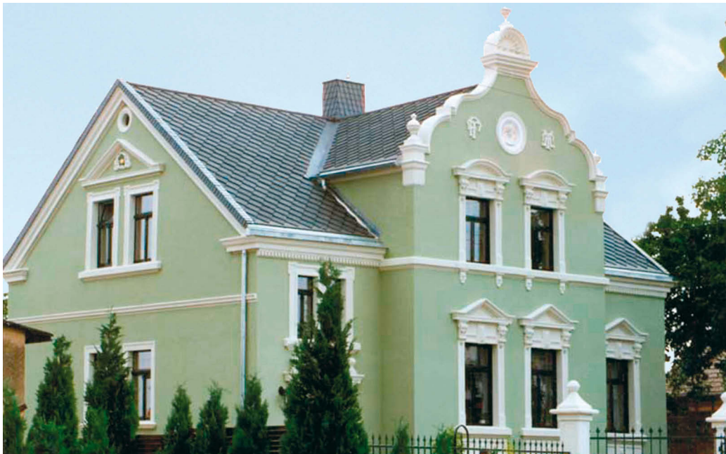
Abb. 2: Modernisierung und Dämmung nach der „Ohnehin-Maßnahme“
